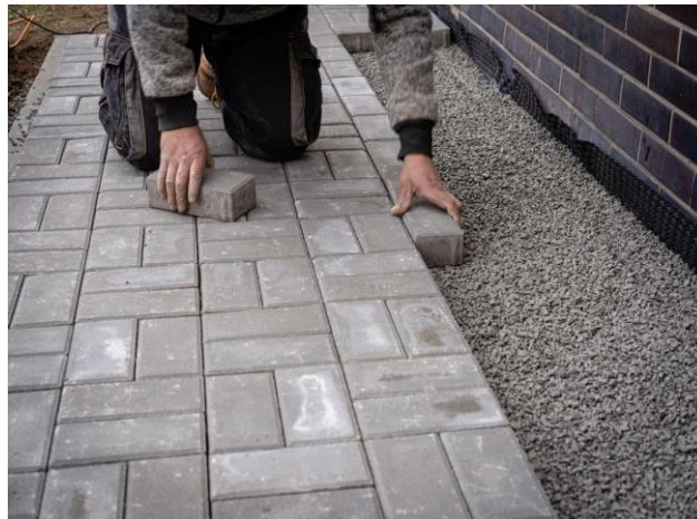
3.5 – Rampa de acesso PcD
