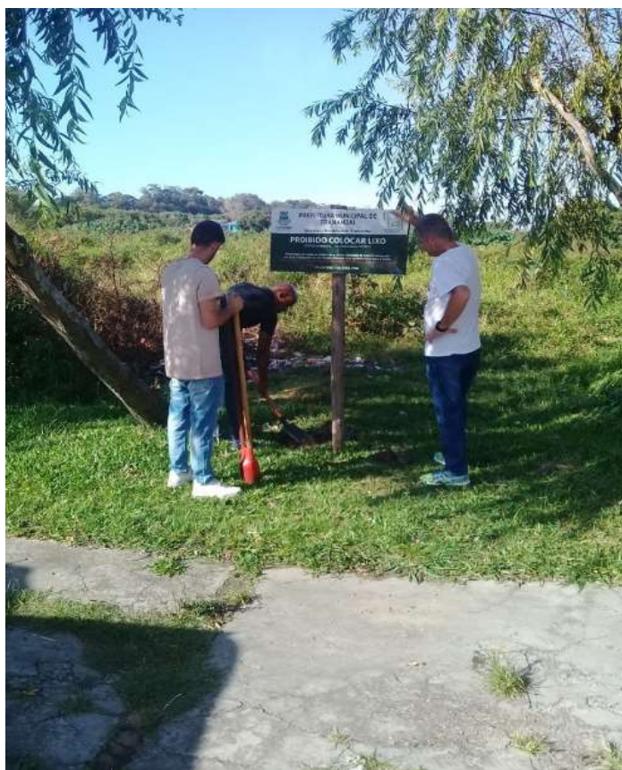
Foto 22: Colocação de placa para conscientização ambiental da população
