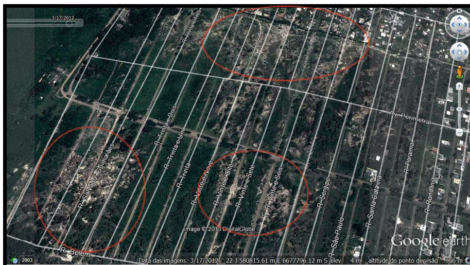
Mapa 12 - Deposição de resíduos de poda e construção civil no Agual
