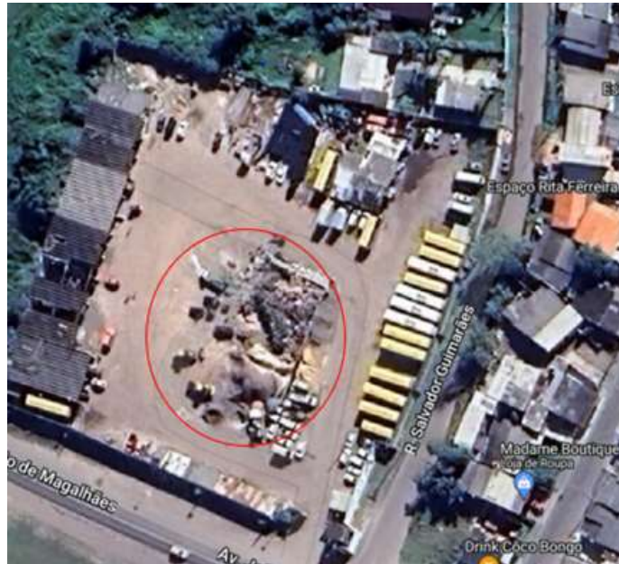
Figura 10: Parque Rodoviário (Usina) utilizado para descarte de resíduos
