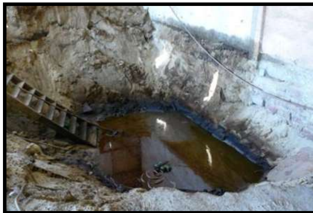
Fonte: Beck de Souza Engenharia LTDA (2013)
