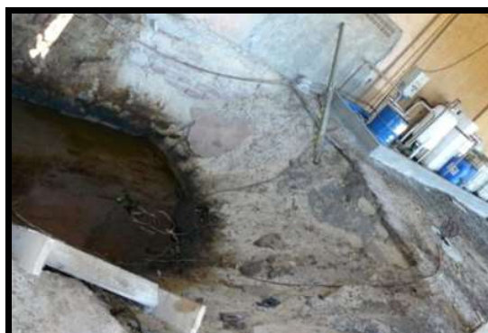
Fonte: Beck de Souza Engenharia LTDA (2013)
